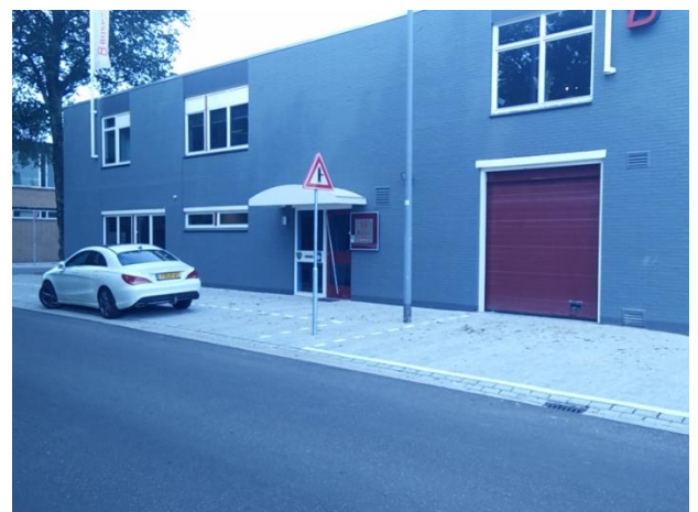
De verkeersborden binnen de parkeerplaatsen zijn grotendeels verwijderd.
